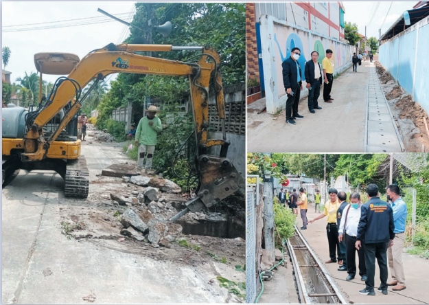
ดำเนินการก่อสร้างรางระบายน้ำ
