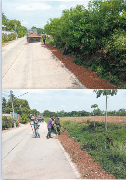
เทหินคลุก ซอยแม่สอด - อัมพาง
