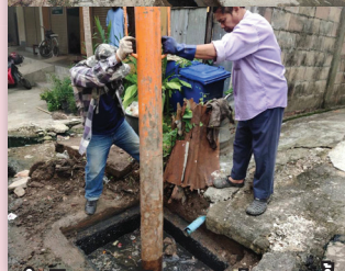
ดำเนินการดูดโคลนออกที่ระบายน้ำและแก้ไขปัญหาน้ำที่อุดตัน
