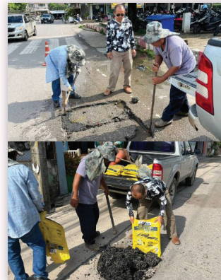
ดำเนินการลงยางมะตอยสำเร็จรูป ซ่อมแซมถนนภายในชุมชน
